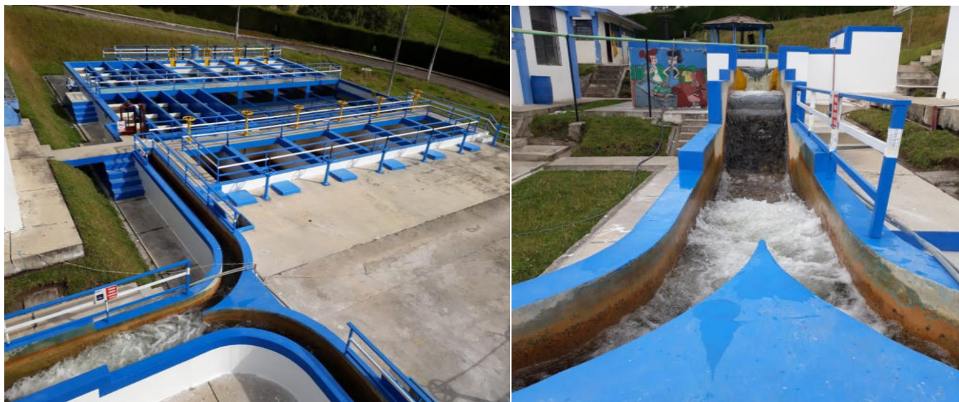
Ilustración 6 Planta de Tratamiento
