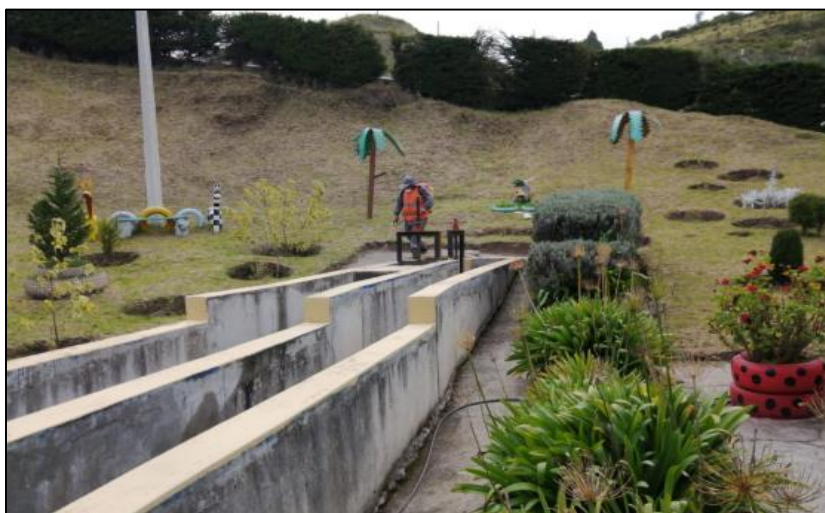
Ilustración 41 Planta de Tratamiento Los Comuneros.
