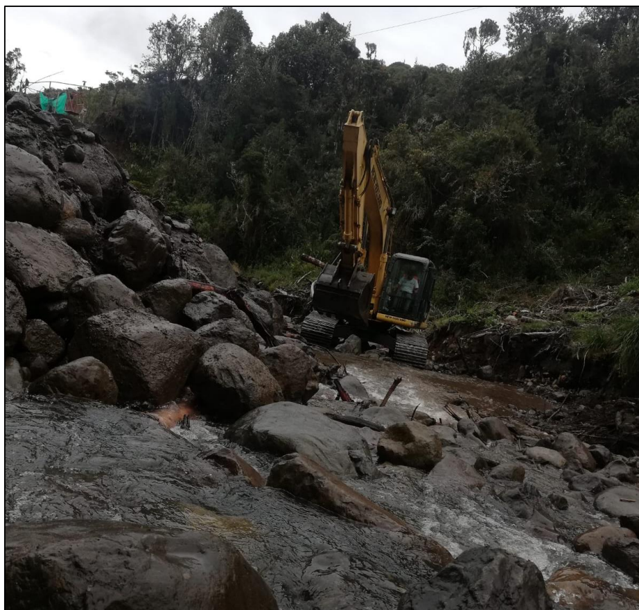
Ilustración 37 Muro de escolleras
