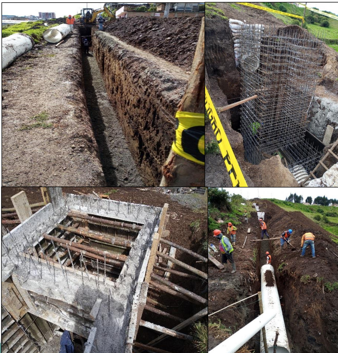
Ilustración 26 Imágenes de trabajos ejecutados en el cambio de colector calle venus y cambio de la red de alcantarillado de la calle Rocafuerte
