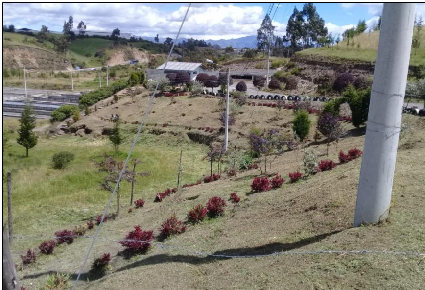
Ilustración 38 Planta de Tratamiento Tajamar
