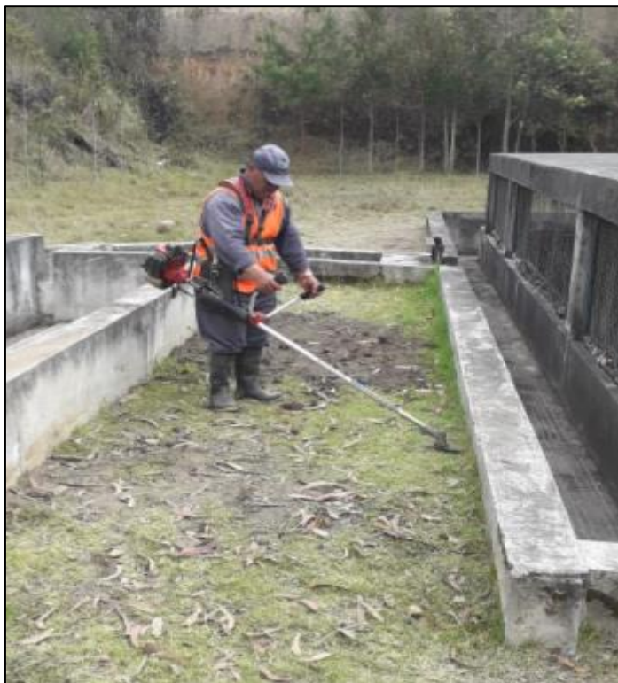
Ilustración 44 Planta de Tratamiento Av. Brasil – (inoperativa)
